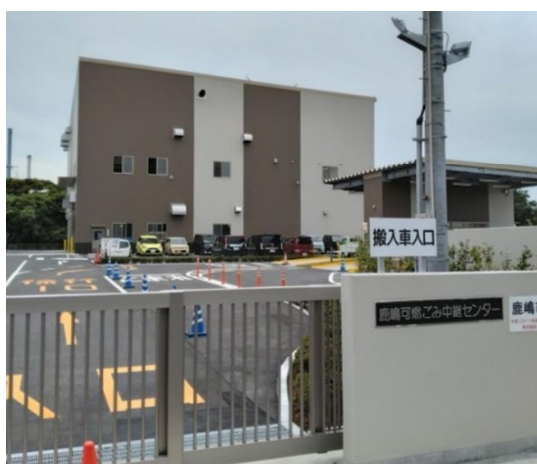
■ 鹿嶋可燃ごみ中継センター
