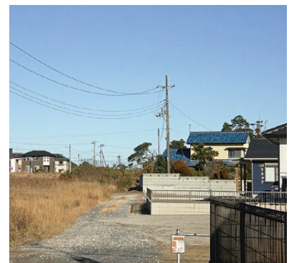
△市道0102号線の2工区として予定されている道路
