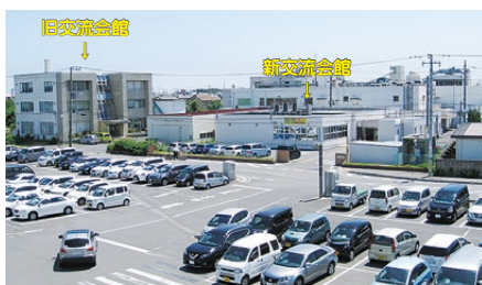
▲左側に見える3階建てが旧交流会館。まもなく解体が行われ、跡地は駐車場になる。
