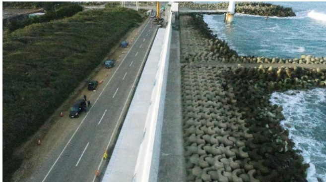
＜海岸防災工事の施工実績＞
