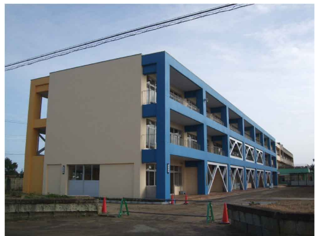
▲ ②平井小学校校舎耐震化工事後
