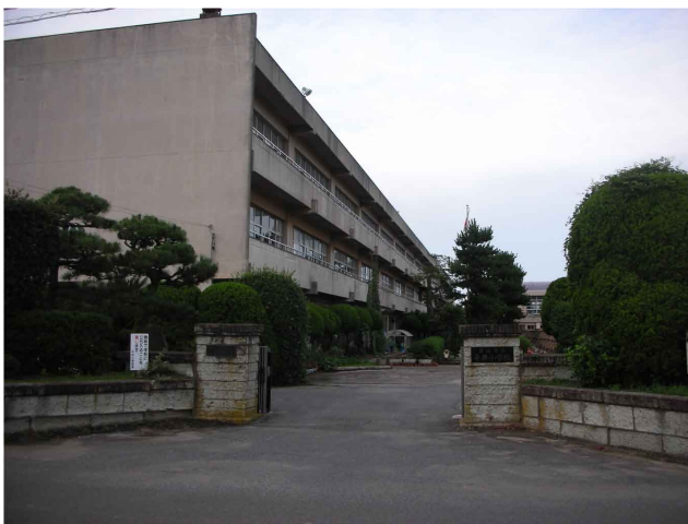
▲ ①平井小学校校舎耐震化工事前
