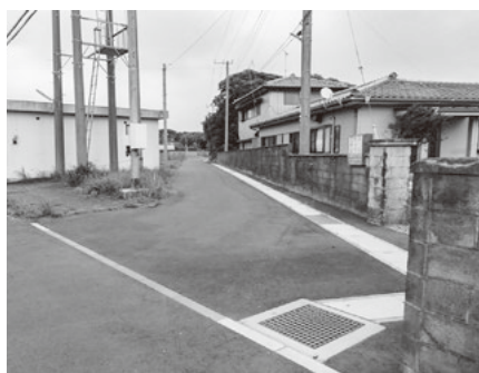
終点が変更された市道2172号線（大小志崎地内）
