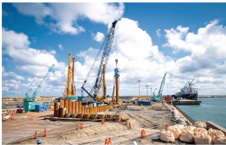
▲基地港湾として必要となる施設整備を進めている鹿島港外港地区 (令和3年11月撮影)
