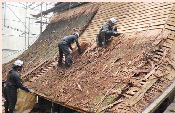
▲奥宮で行われている修繕作業
