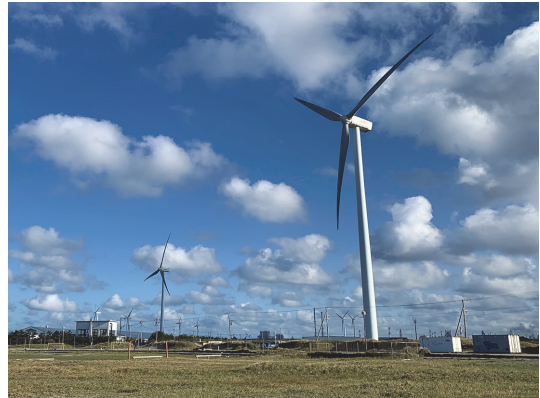
風力発電施設
