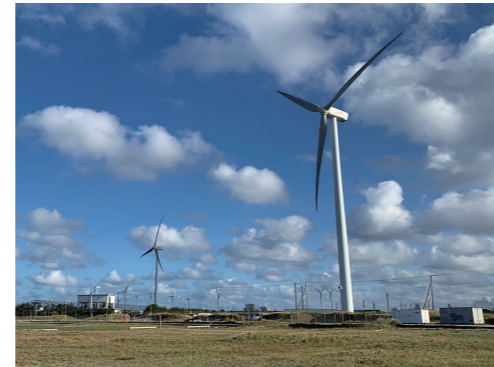
風力発電施設
